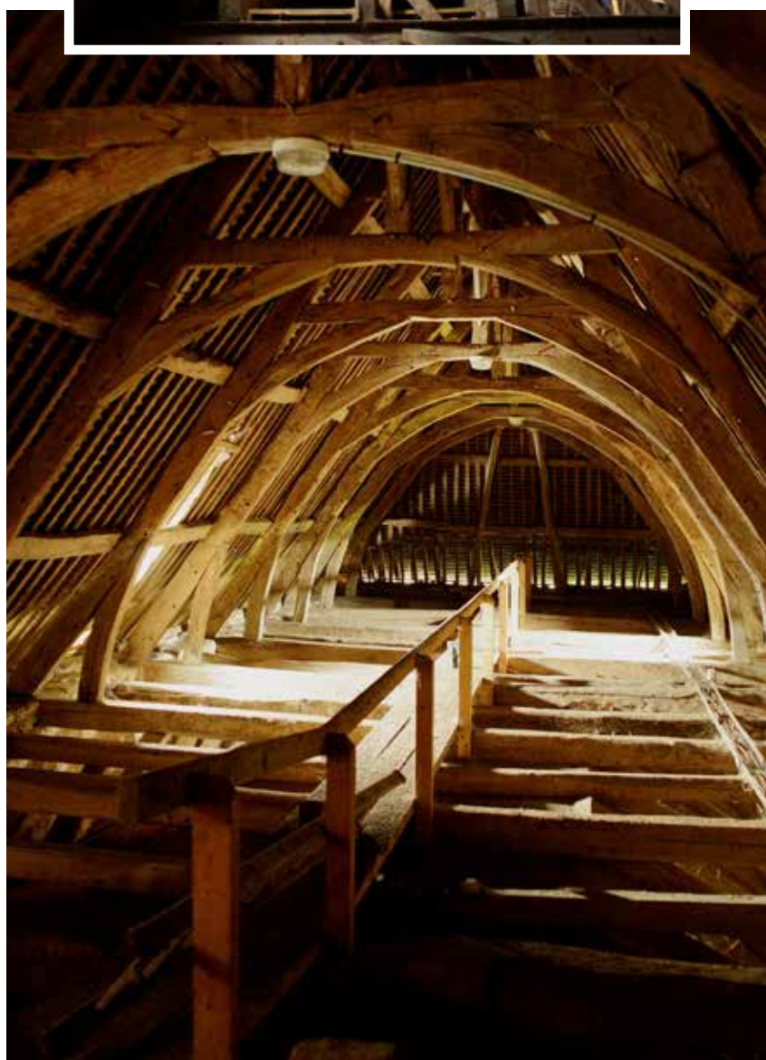
Au delà du clocher s'étend la charpente de la nef.
