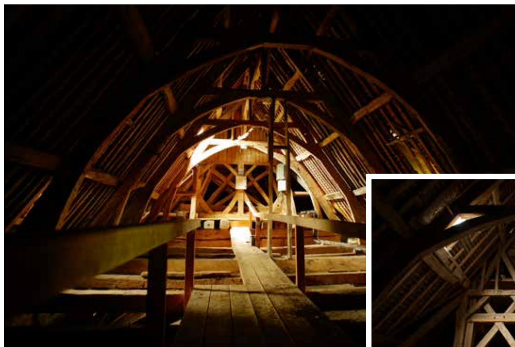
L'échelle de meunier donne accès à la charpente du chœur, traversée par une étroite passerelle qui surplombe la voûte jusqu'à la base du clocher.
